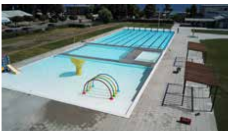
Kantarellbadet i Åhus. Den tidigare 50-meters bassängen är nu helt ombyggd till fyra nya bassänger
